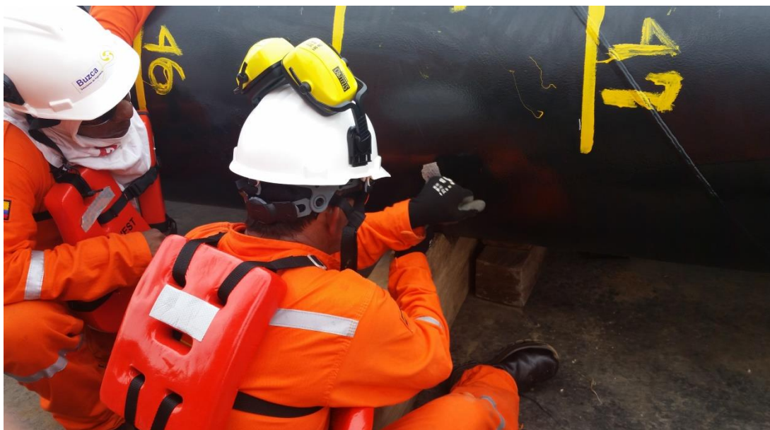
Figura 6. Ejecución de perforaciones para la fijación de sensores y transmisores inalámbricos
